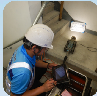
地下排水系統閉路 電視及聲納勘測
