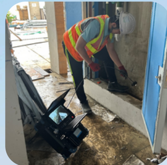
建築物排水管和 管道閉路電視勘測
