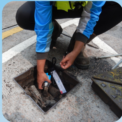
地下供水管道漏水檢測
